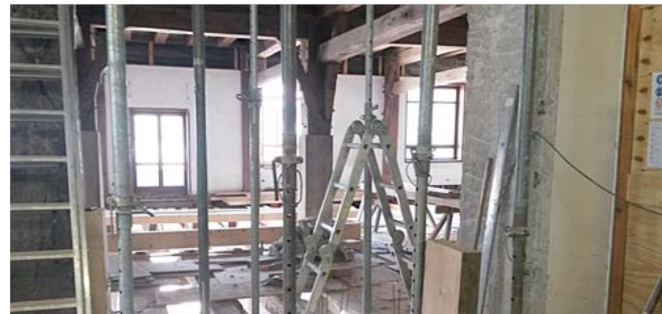
Teilweise wurden bestehende Räume komplett entkernt, um anschließend auf dem alten Tragwerk mit modernsten Baumethoden brandschutztechnisch qualifizierte Bauteile herzustellen. Die historischen Wandoberflächen wurden dabei so oft wie möglich wiederverwendet.
