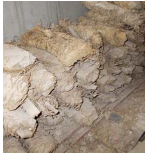
Neben Fachwerkwänden wurden im Roten Bau auch Strohlehmwickel als Füllung des Zwischenkerns in der Holzbalkendecke verbaut.
